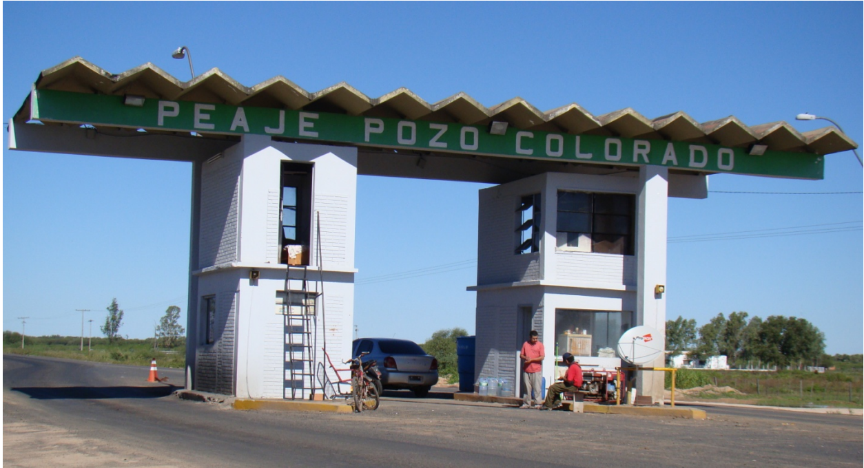
Estación de peaje, Pozo Colorado, 2010.
