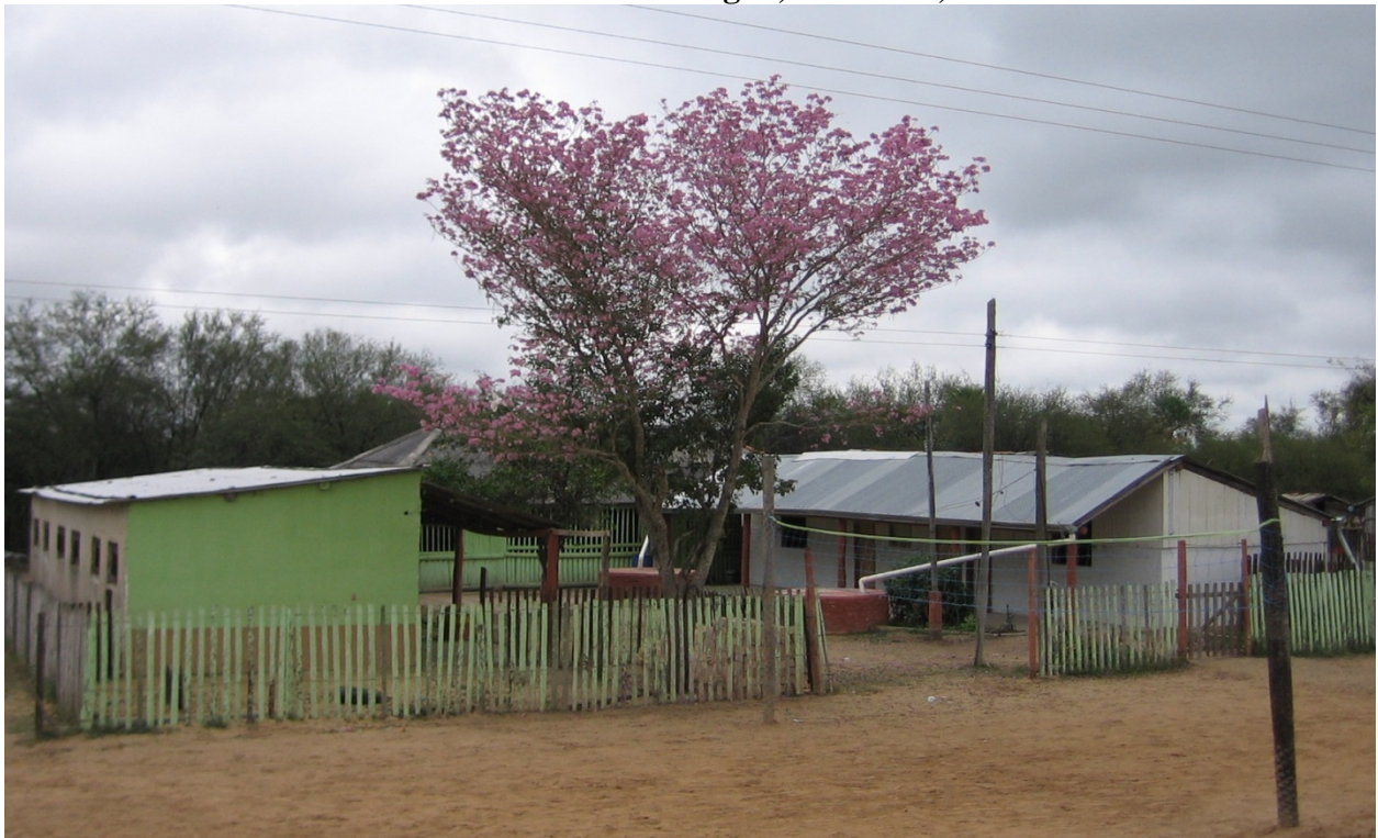
Casa con colectores de agua de lluvia y aljibes para su almacenamiento. Ruta Transchaco.
