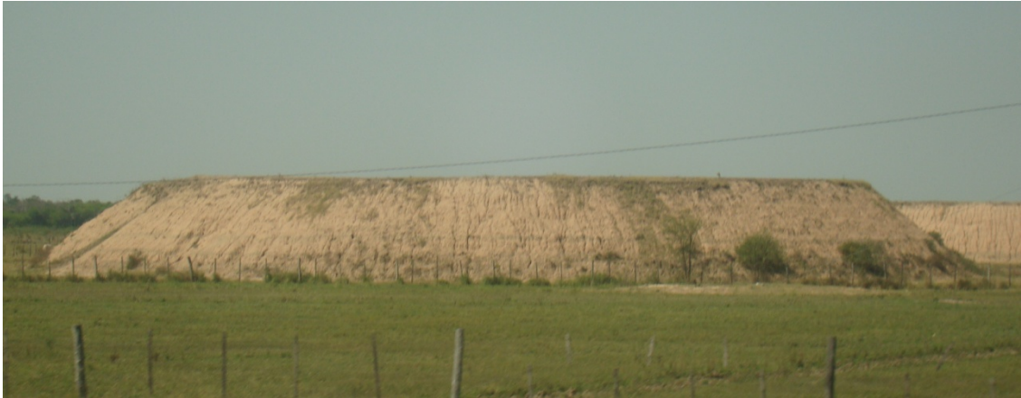
Tanque Australiano, método típico de captación y almacenamiento de agua de lluvia en El Chaco.
