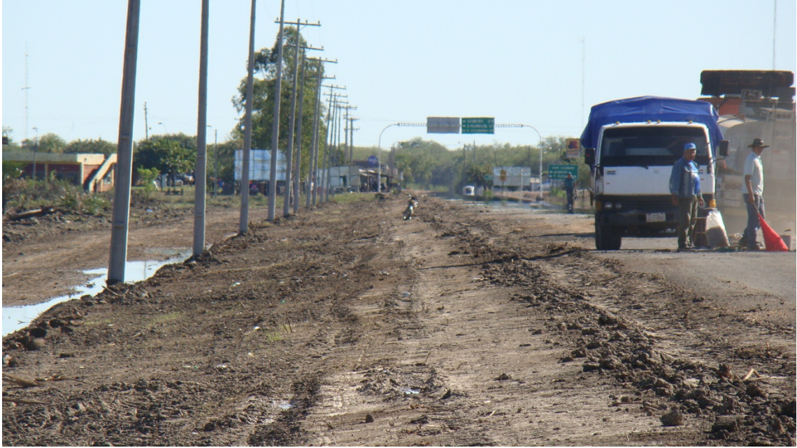
Reparación Ruta a Concepción, Cruce Pozo Colorado.
