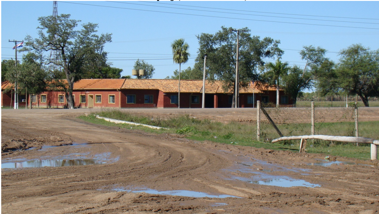
Instalaciones del Ejercito, Pozo Colorado, 2010
