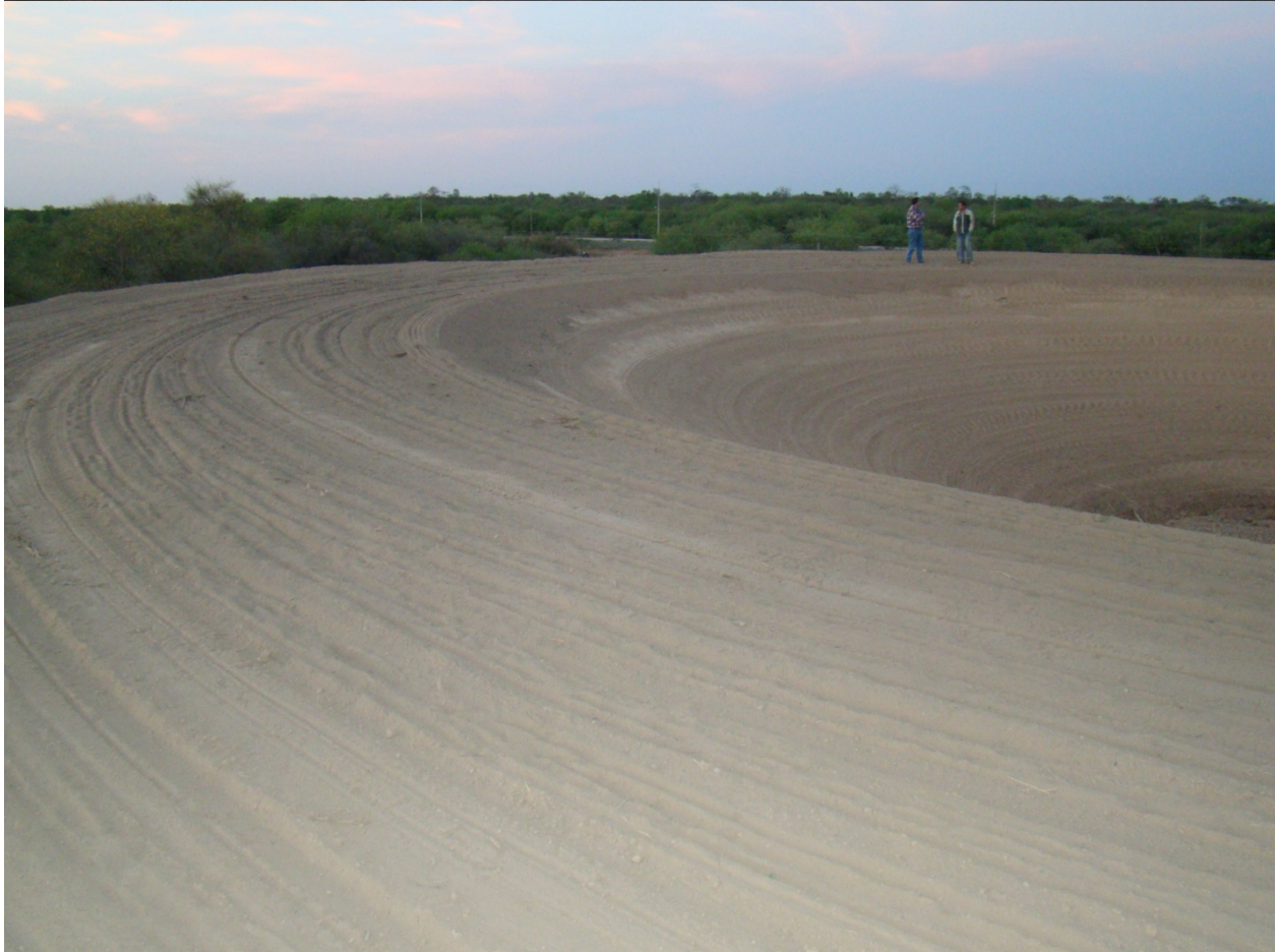
Tanque Australiano en construcción en Loma Plata, 2010.
