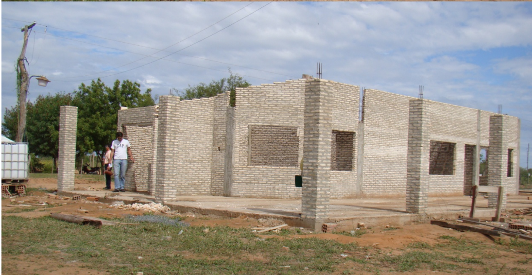
Polideportivo en Construcción, Irala Fernández, 2010.
