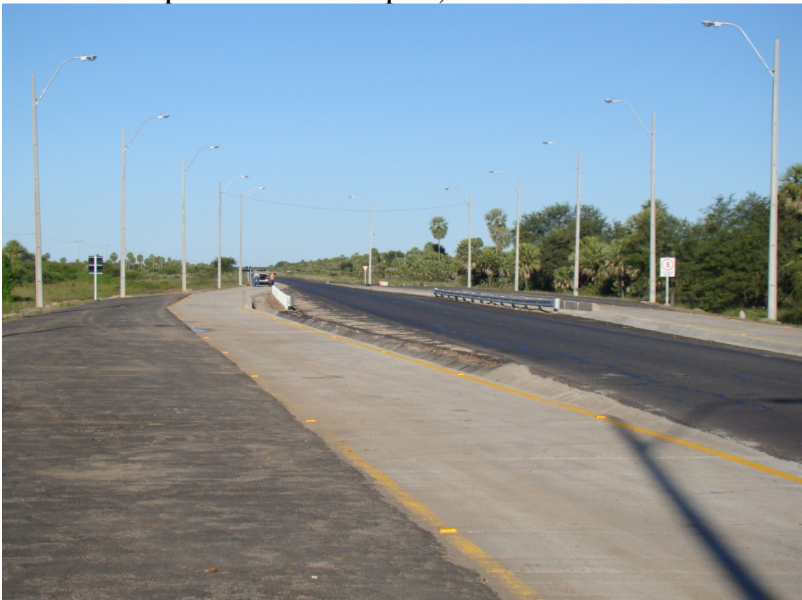
Construcción Estación de Control de Peso en el Transporte Pesado, Pozo Colorado, 2010.
