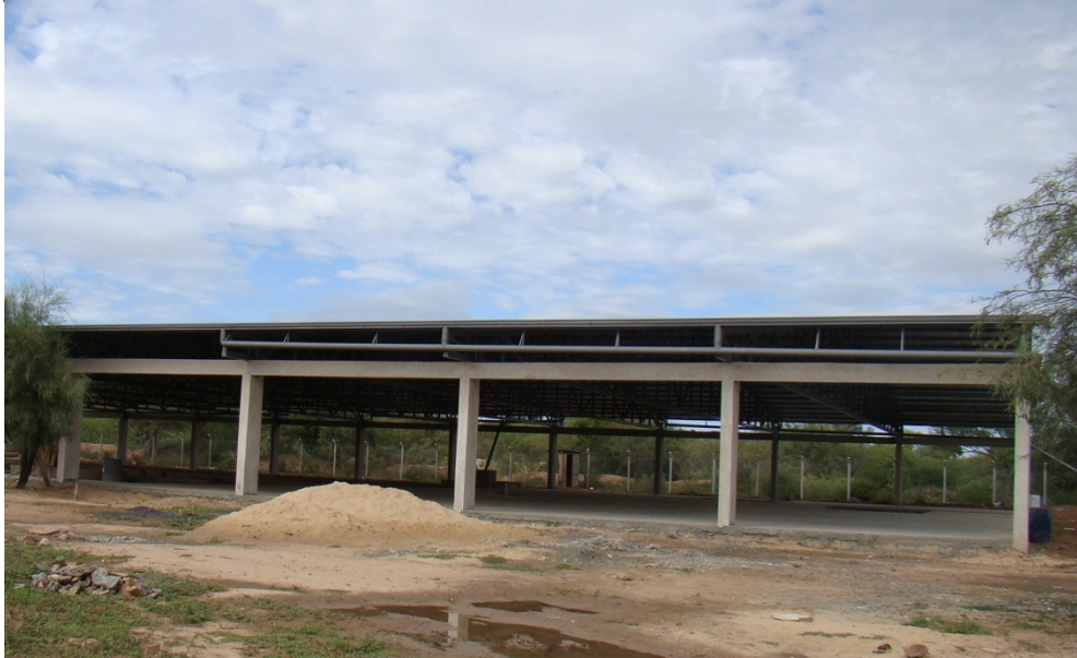
Municipalidad en Construcción y Desalinizadora en construcción, Irala Fernández, 2010.
