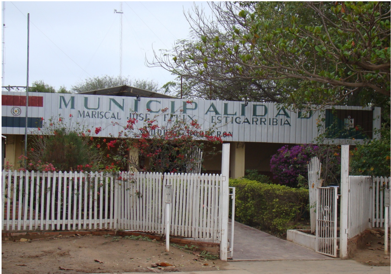
Entrada principal a la Municipalidad, 2010.
